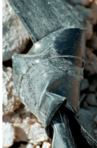
Am tiefer gelegenen Feldende werden die Schläuche verknotet.
